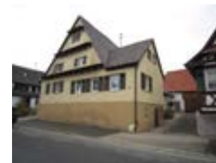
Hauptstraße 36 (rechter Hausteil), von SW
