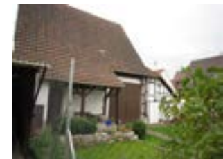
Kappelstraße 6 Scheune, von NO
