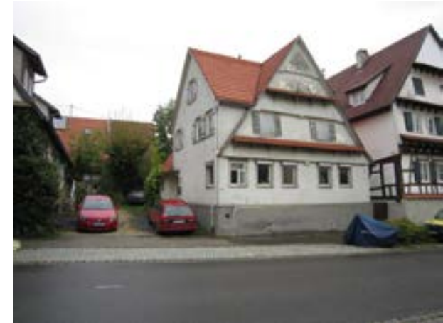
Hauptstraße 14, von SW
