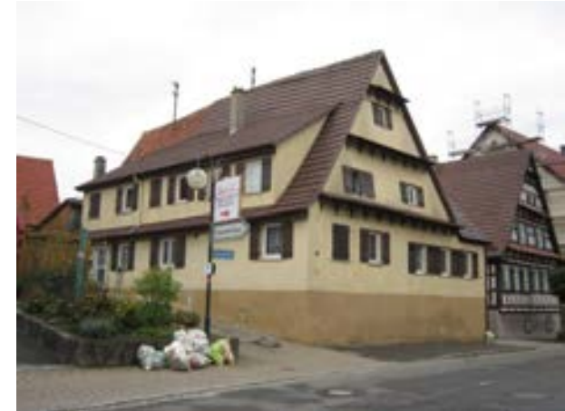
Hauptstraße 36 (rechter Hausteil), von NW
