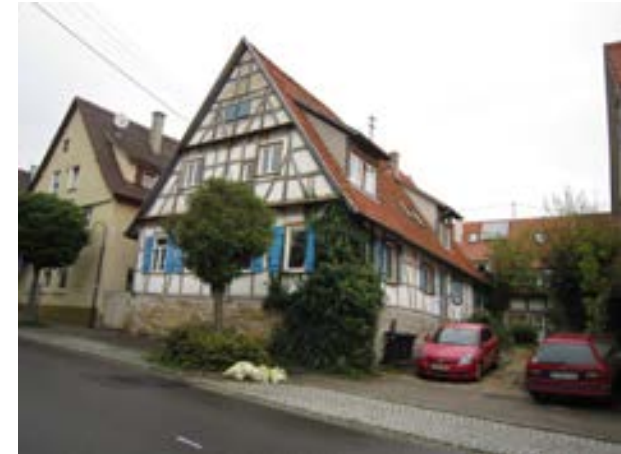
Hauptstraße 16, von SW
