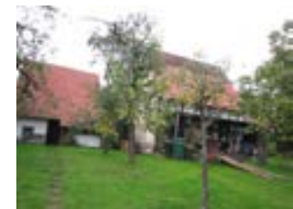
Hauptstraße 36/1 Scheune, von SO, von der Kirchstraße
