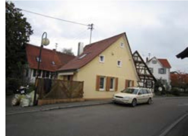
Gomaringer Straße 1, von SO
