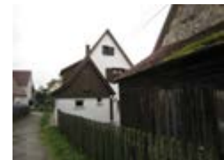
Hauptstraße 17, von SW
