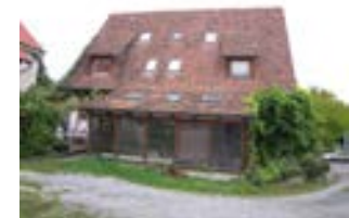
Hauchlinger Straße 27, Rückseite, von SW
