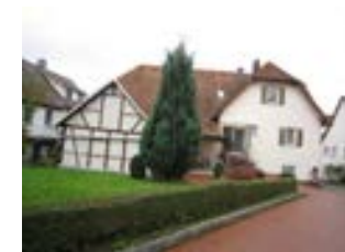
Luppachstraße 14, Rückseite, von NW
