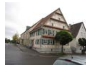
Bohlstraße 2, außen, von W
