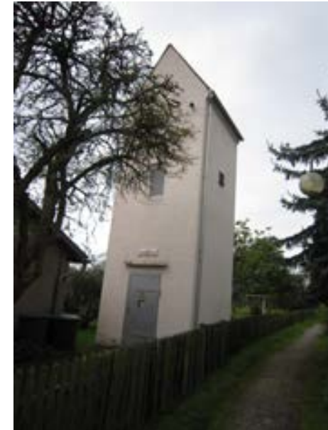
Hauptstraße 17/1, Umspannstation, von SW
