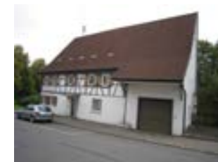
Luppachstraße 39, von SW
