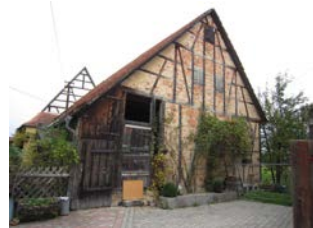
Kappelstraße 17, von SO, Scheune zu Kappelstraße 21
