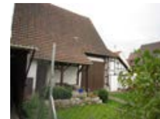
Kappelstraße 4 Scheune, von NO
