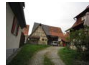
Hauptstraße 33 (rechts) mit Scheune 33/2 und Nebengebäude 33/1, von NO
