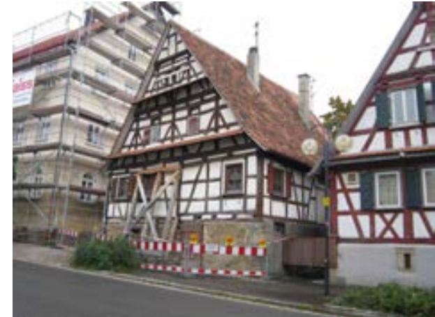
Hauptstraße 30, von SW
