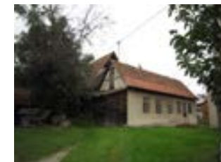
Hauptstraße 12/3 Scheune, von S
