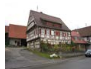
Luppachstraße 6, von SW, im Hintergrund Scheune Luppachstraße 6/1
