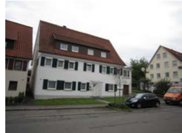
Luppachstraße 23, von NW
