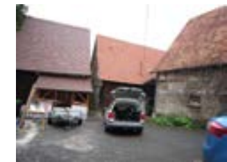
Hauchlinger Straße 26/2 und 28/2, Scheunen, von SW
