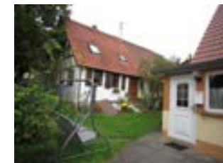
Gomaringer Straße 3, von SO
