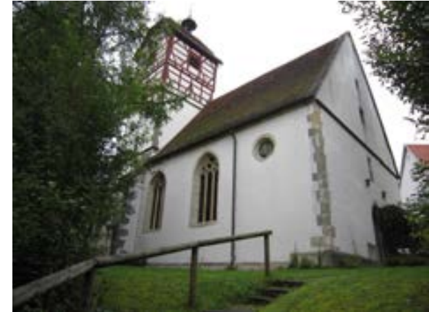
Hauchlinger Straße 30, ev. Veitskirche, von NW
