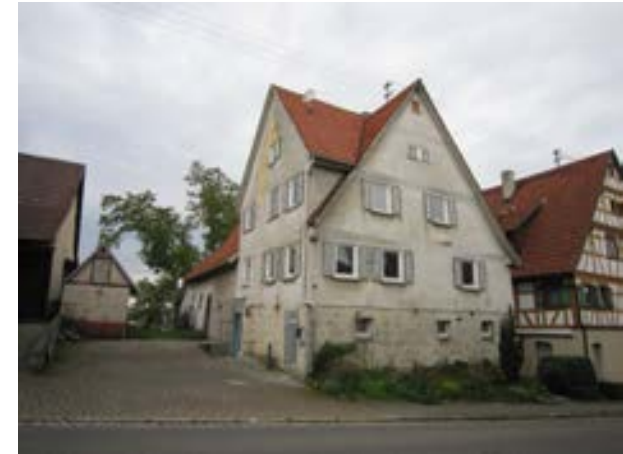
Hauchlinger Straße 39, von S
