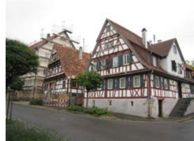
Hauptstraße 28, von SW
