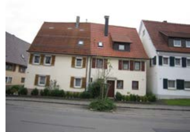
Luppachstraße 19 (links) und 21 (rechts), von NW
