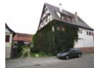
Oper 1, von O, Straßenansicht
