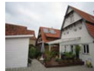
Bild Hauptstraße 31, Rückseite, von SW
