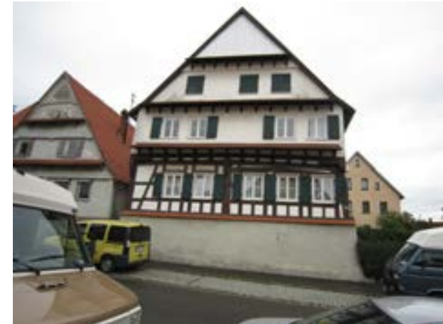
Hauptstraße 12, von SW
