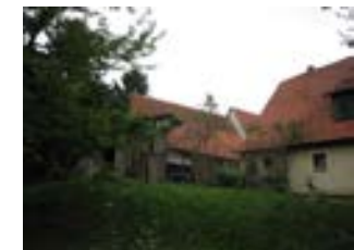
Kappelstraße 9, von NW, links Scheune
