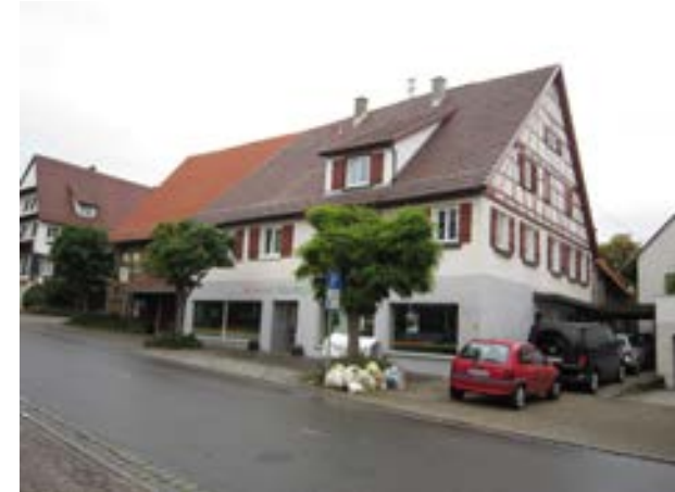
Hauptstraße 6, von SW
