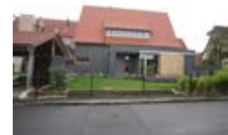
Hauptstraße 34, ehemalige Scheune, von O, von der Kirchstraße
