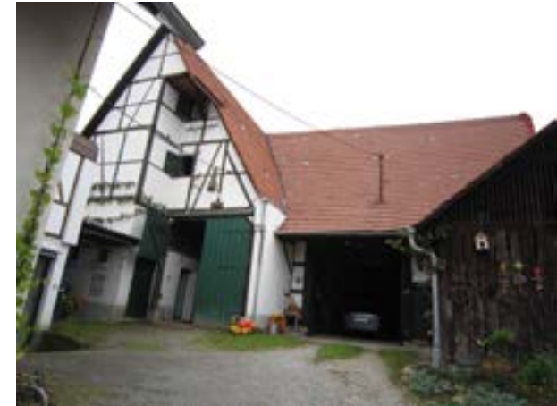
Luppachstraße 8, Scheune, von SO
