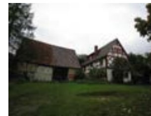
Hauptstraße 9 und Scheune 7/1, von SO
