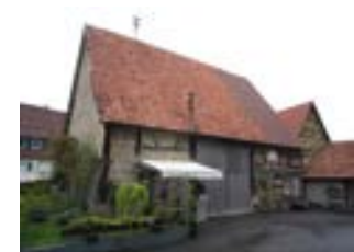
Hauchlinger Straße 22, Scheune, von SO
