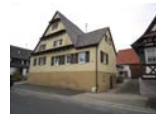
Hauptstraße 38 (linker Hausteil), von S
