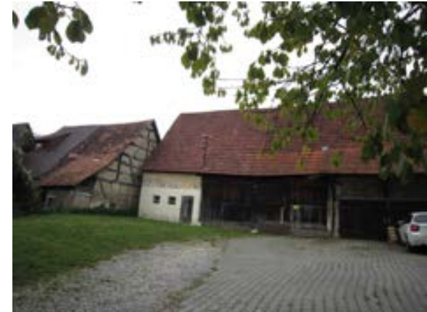
Hauptstraße 15/1 Scheune, von NO
