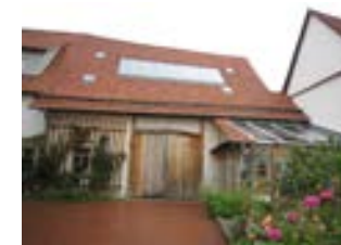
Luppachstraße 16/1 Scheune, von SO
