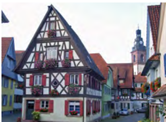
Haslach, ehemaliges Bergamt
